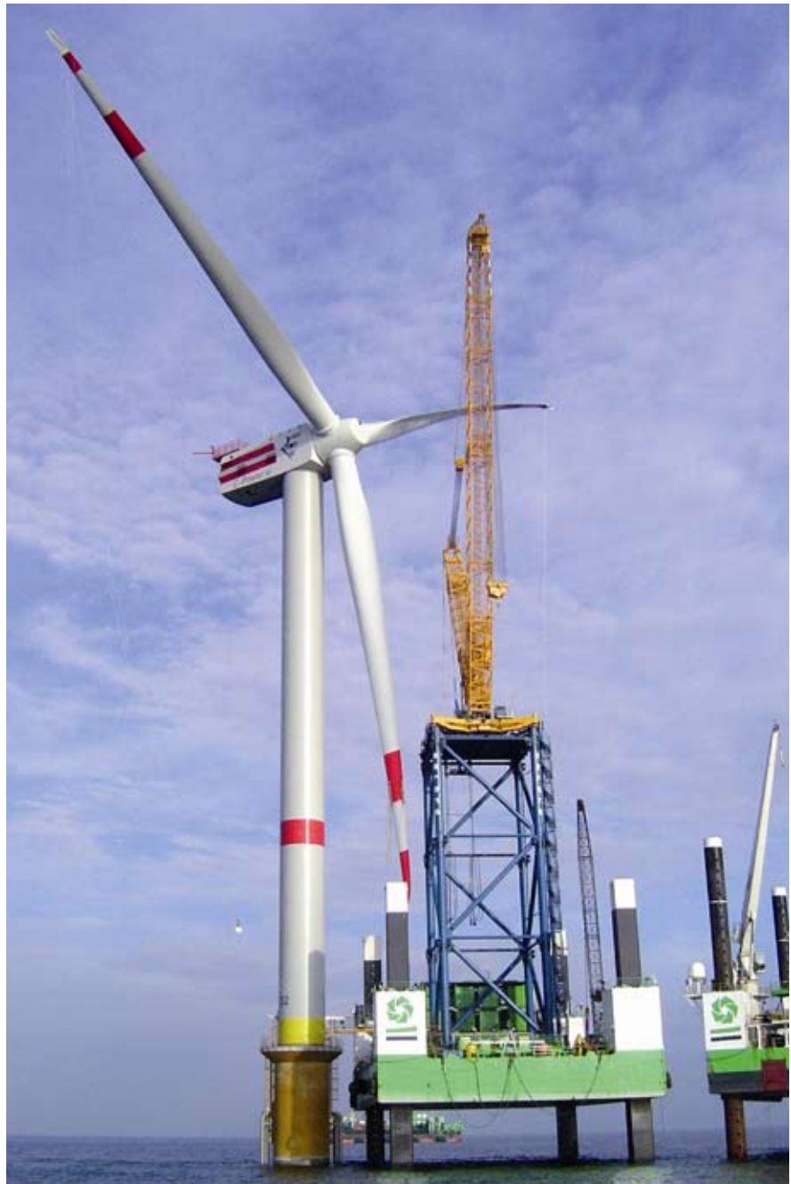
La instalación de los primeros seis aerogeneradores completó la primera fase del proyecto belga de Thornton Bank en septiembre de 2008. Foto: Jan Oelker
