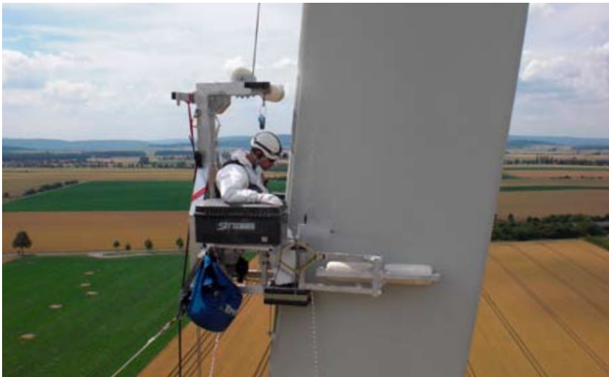
SkyChair-Prototyp wird an einer Windkraftanlage in Deutschland getestet. Die letzten technischen Änderungen wurden nach praktischen Vorschlägen von Technikern vorgenommen.
