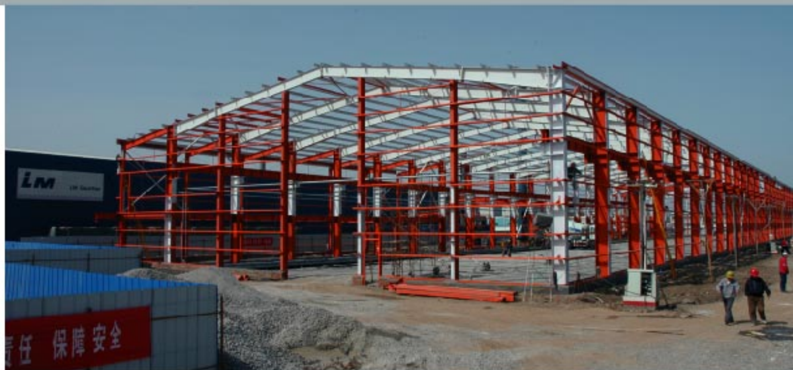
LM Glasfiber从2001年起就在中国拥有一家生产工厂。沿着现有工厂正在建设的是新的厂房，预计在2006年的夏天投入生产。
