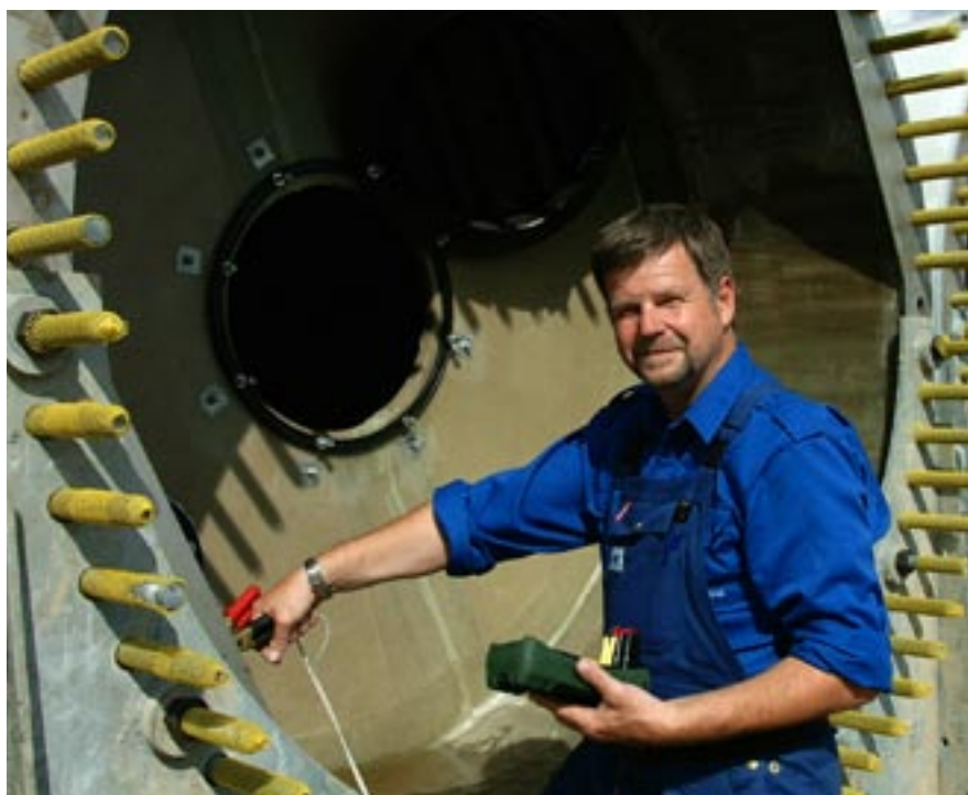
Teknikeren Lars Chr. Frederiksen, LM Glasfiber er med de systematiske 4-punkts modstandsmålinger med til at sikre vingernes lynbeskyttelsessystem.
