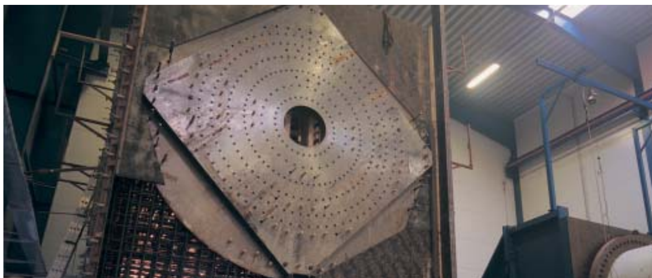
Det er krævende at bygge konstruktioner, som opfylder kravene til testning af meget store vinger.
