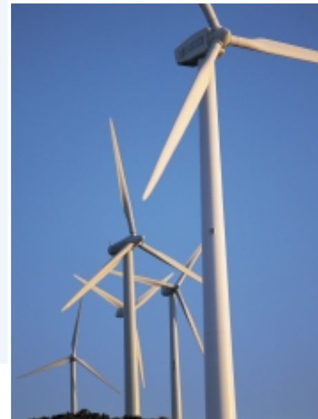
Gegenwärtig sind im Windpark 24 WEA installiert, von denen 20 mit LM-Rotorblättern ausgestattet sind.
